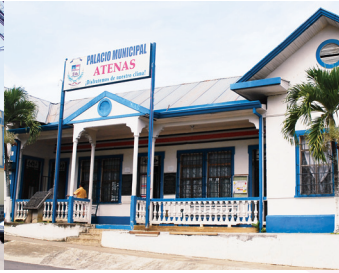
Edificio municipal de Atenas
